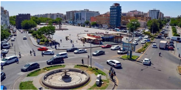
Görsel 22. Dağkapı Meydanının son hali 2025
