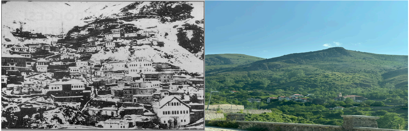
Şekil 1. Gümüşhane Süleymaniye Mahallesi 1900'lü yıllar (URL-2) ve Günümüz (Çelenk Çavdar, 2025)
